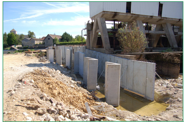
Passes à poissons en construction (photo : RIVE de la Vienne)
